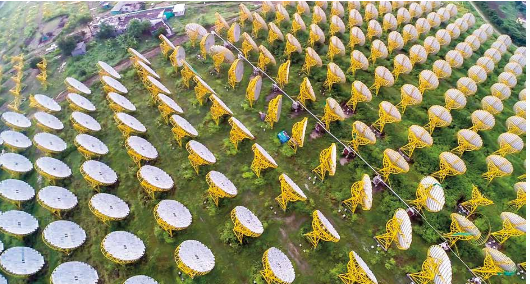
India One Solar Thermal Power Plant, Rajasthan, Indien, 2014
